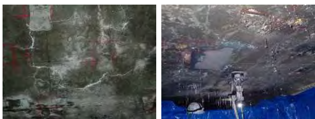
写真-3 変状部の状況 写真-4 施工(洗浄)状況
