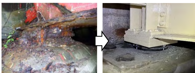
写真-6 支承取替 (左:補修前, 右:補修後)
