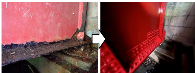
写真-5 主桁補強状況
