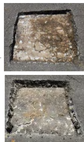
写真ー2 舗装剥離調査 (上: A, 下: B)
