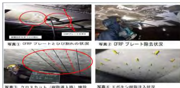
写真-8 CFRP プレート工法の再補強 天白橋施工状況
