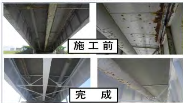
写真-5 鋼板接着工法の再補強 鮭川橋
