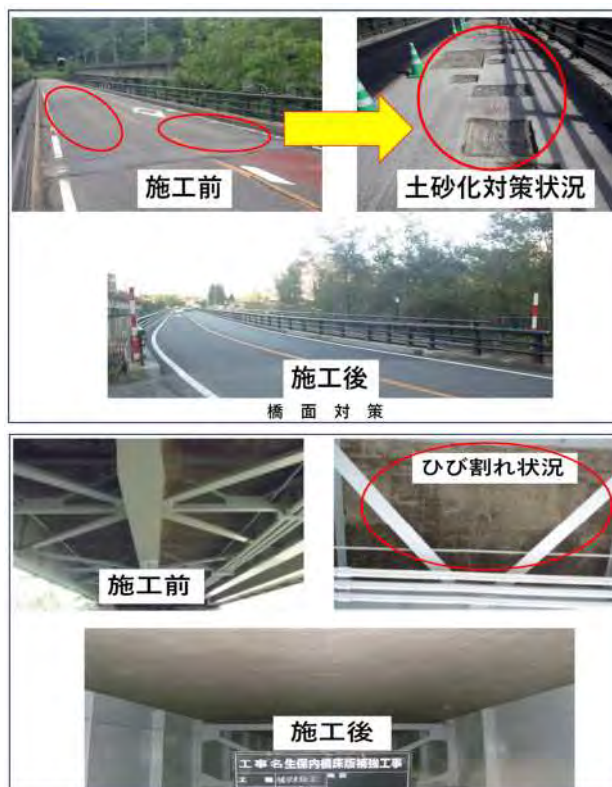
写真-3 B 活荷重補強 生保内橋
