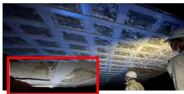
写真-7 CFRP プレート工法の再補強 天白橋
