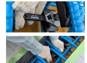
(f) 鋳鉄金物 (T 型) の設置状況
