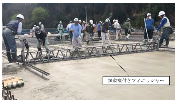
写真-1 RC床版上面の一次仕上げ
