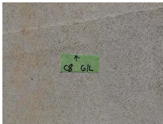
写真-6 材齢 10 ヶ月の表面性状（一次仕上げなし）
