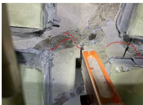
図-16 床版下面のひび割れの状況
