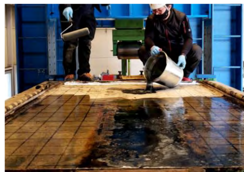
写真-6 注ぎ込みによる補修状況
