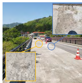
写真-1 RC 床版上面における砂利化と鉄筋露出
