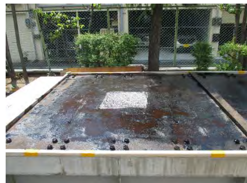
写真－3 アスファルト乳剤の散布状況
