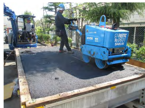
写真－4 アスファルト混合物の舗設状況
