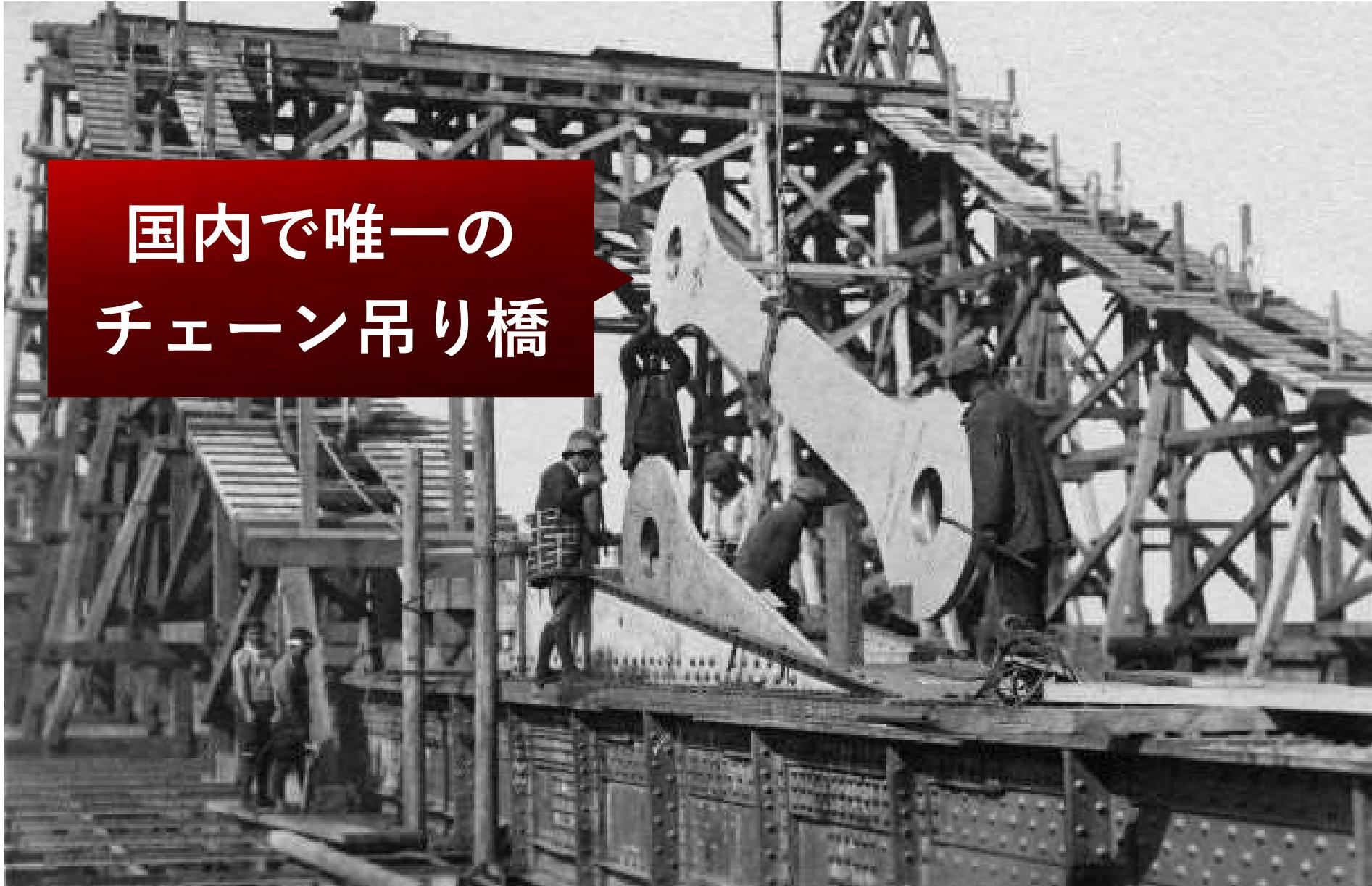
世界では吊橋の吊材は、チェーンからケーブルへ
