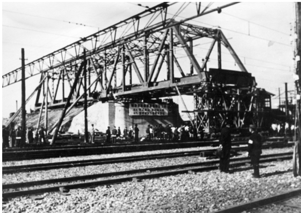
城海津跨線橋の架設工事
