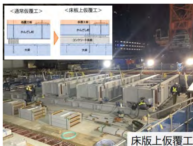
図－9 床版上仮覆工の設置状況
