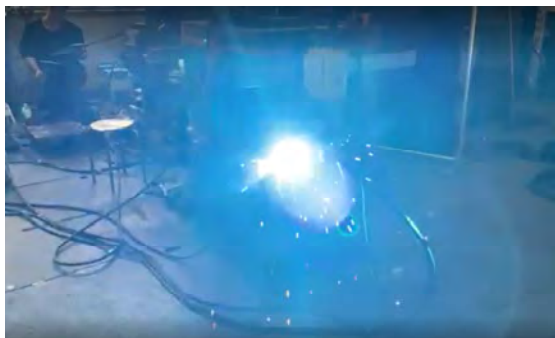
(a) 溶接施工試験中の状況
