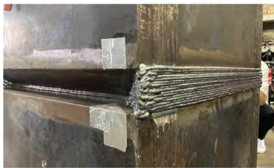
(b) 溶接後の外観
