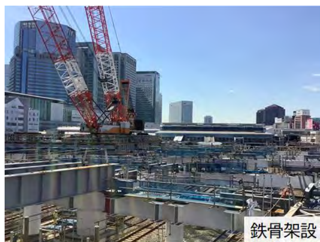
図－8 複数クレーンの配置状況
