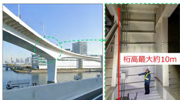
図－1 2 高所点検箇所
