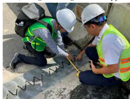
写真-17 IIA スタッフの橋梁点検状
