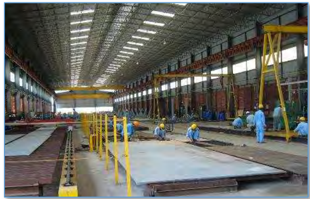
写真-5 ニャットン橋製作状況
