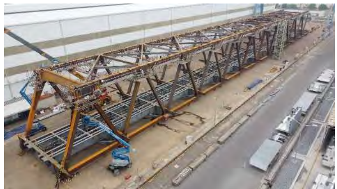
写真－3 工場内での仮組立状況
