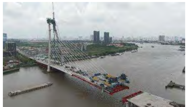
写真-11 架設状況
