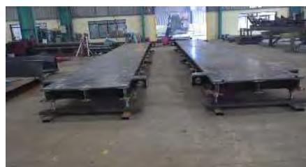
写真-1 6 Active Mass Damper 構台の芯出し作業状況
