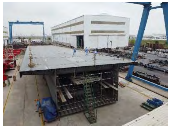
写真-9 MTHL 仮組立状況
