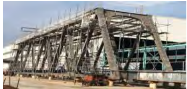
写真-7 仮組立状況
