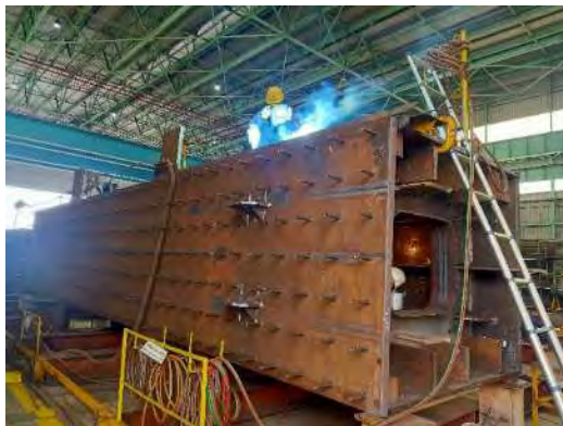
写真－2 工場内での製作状況
