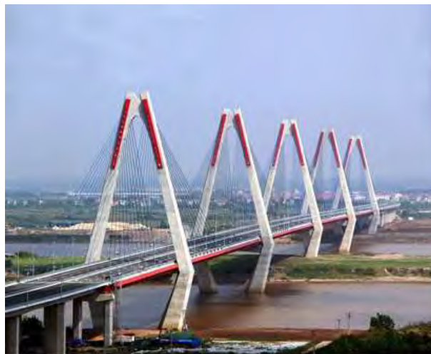
写真-4 ニャッタン橋
