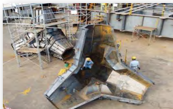
写真-1 4 型枠の仮組作業状況
