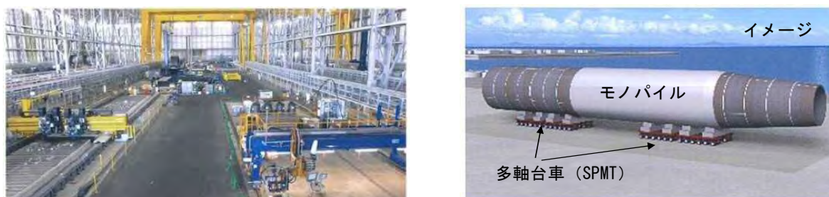
図3-4 工場内門型クレーンおよび多軸台車移動
