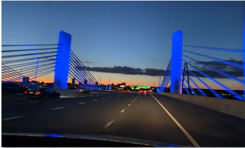
写真－3 コネチカット州の点検対象橋梁
