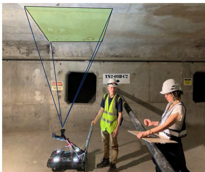
写真－５ 箱桁内における画像撮影状況
