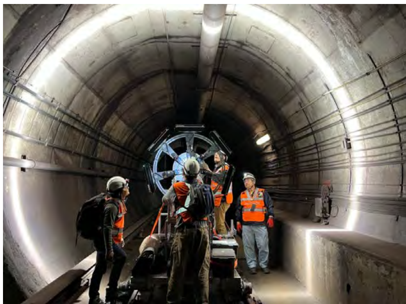
写真－２ ワシントン・メトロ地下鉄トンネルの点検の様子
