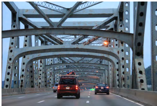
写真－ 1 オハイオ州における道路橋床版点検の状況
