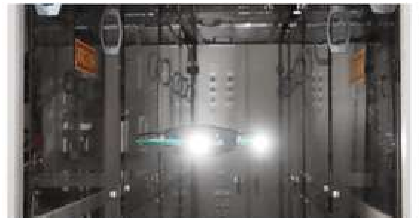
狭小空間での飛行状況(撮影協力:日本リーテック(株))
