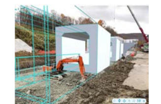
掘削作業時にARと比較
