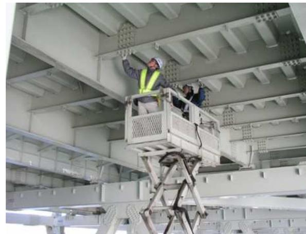
桁内面作業車を使用した点検
