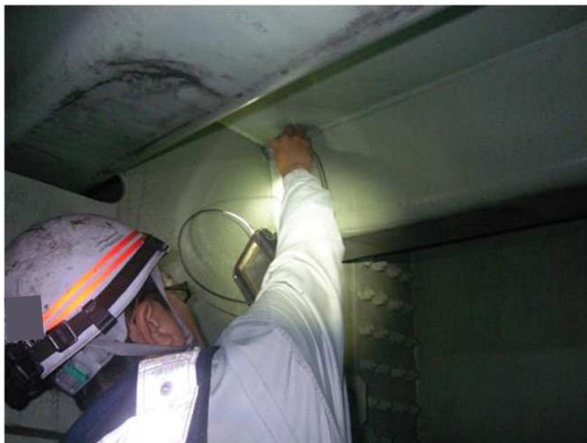
Uリブ鋼床版溶接部での渦流探傷試験(ET)
