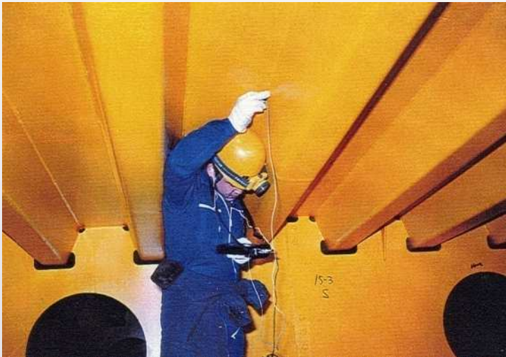
Uリブ溶接部の探傷状況
