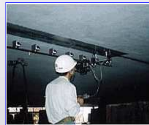
下フランジ突合せ溶接部
