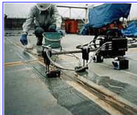
鋼床版突合せ溶接部
