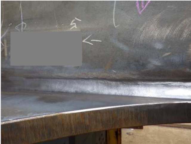
溶接仕上げ部の外観
