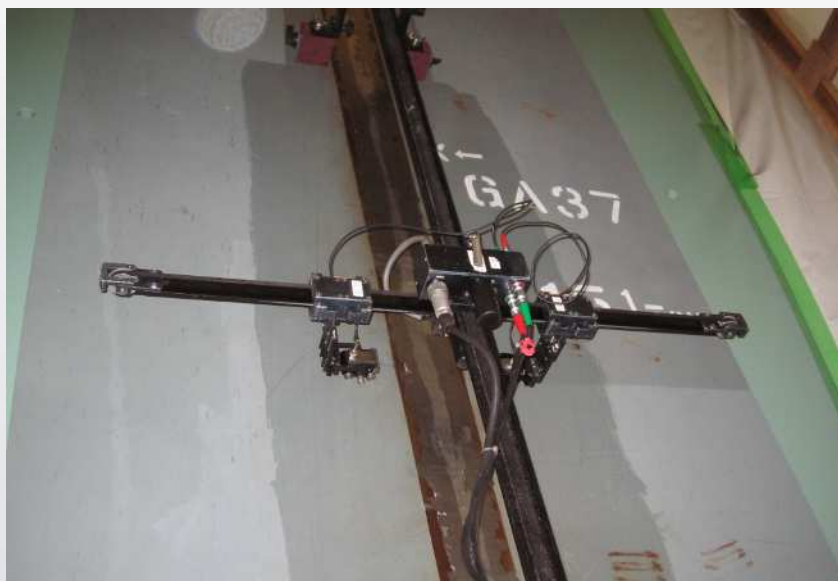
ウェブ突合せ溶接部
