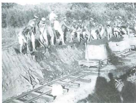
写真-1 連隊軌道敷設訓練風景(明治末期~昭和7年頃 八柱附近)
