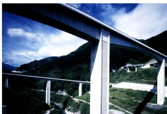
写真 6-1 雷電廿六木橋（1998 年竣工）
