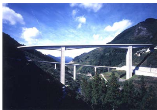
写真 6-2 滝沢ダム着工前の雷電廿六木橋
