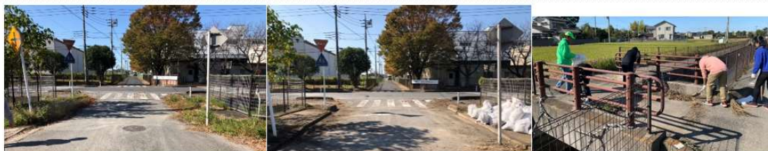
写真6-29 加須市の橋梁の簡易点検と苔泥清掃活動（左：清掃前，中：清掃後，右：作業中）
