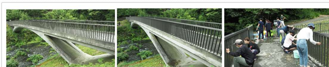
写真6-30 富士宮市白糸ノ滝に架かる滝見橋（左：清掃前，中：清掃後，右：清掃中）
