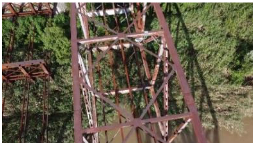
写真2 UAV撮影による上弦材の外観 1)
