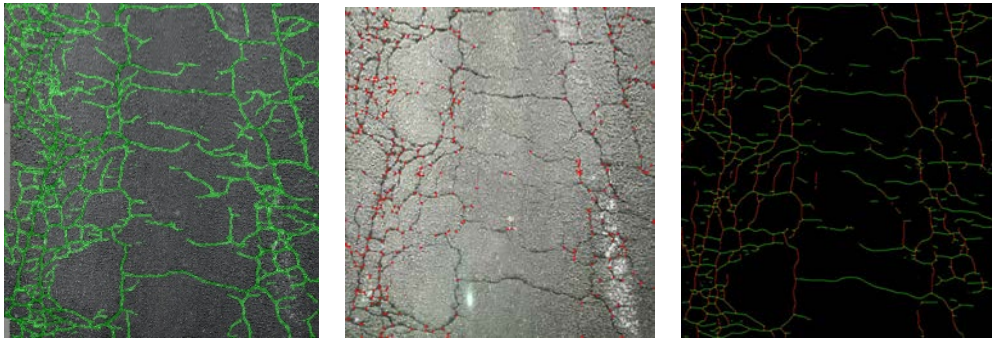
図2 ひび割れ抽出とひび割れ特徴量の算出 1)
