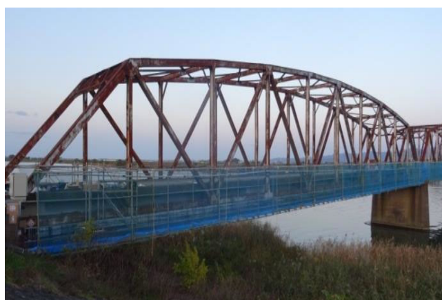
写真 1 旧布施田橋トラス橋部外観 1)
