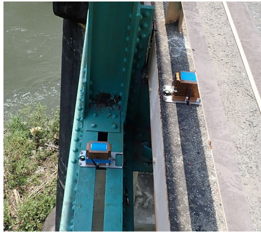
図 3 加速度計の設置状況
