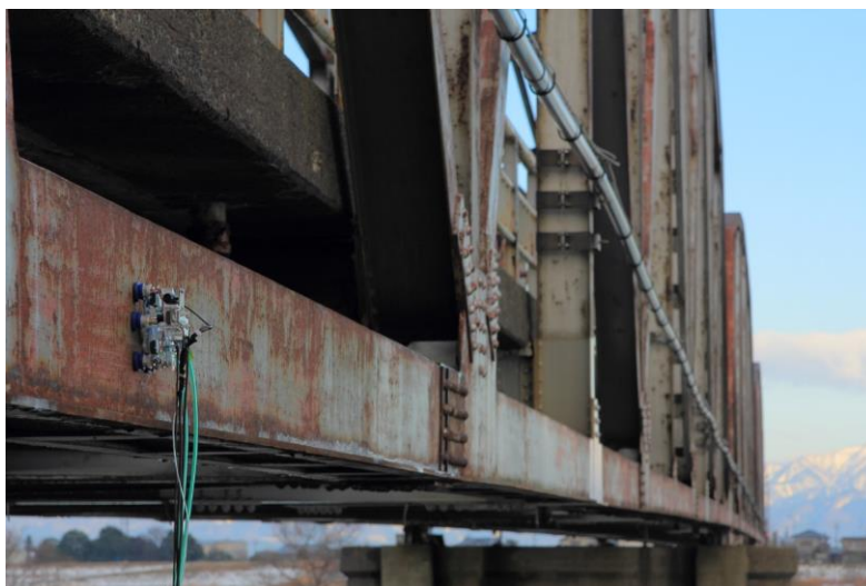
図3 実橋梁での適用検証実験の様子
