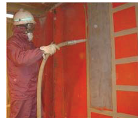
塗膜の剥ぎ取り作業の一例 [国土技術政策総合研究所資料]
