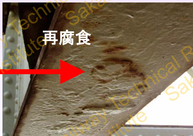
塗膜下での再腐食例
