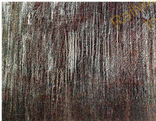
手工具を使用した場合 (除錆度-3)
