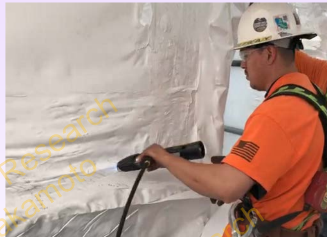
熱収縮シートの融着作業
