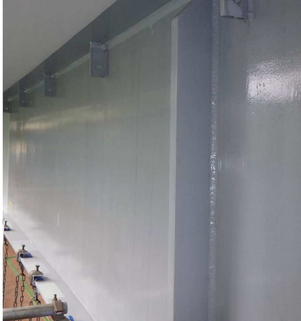
↑ 上塗り塗布完了状況
