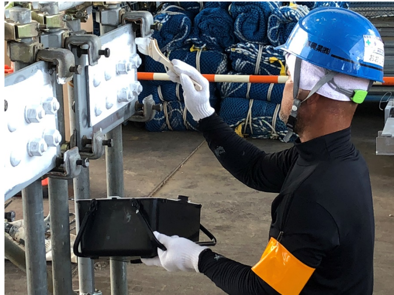
↑ 下塗り塗布作業状況
