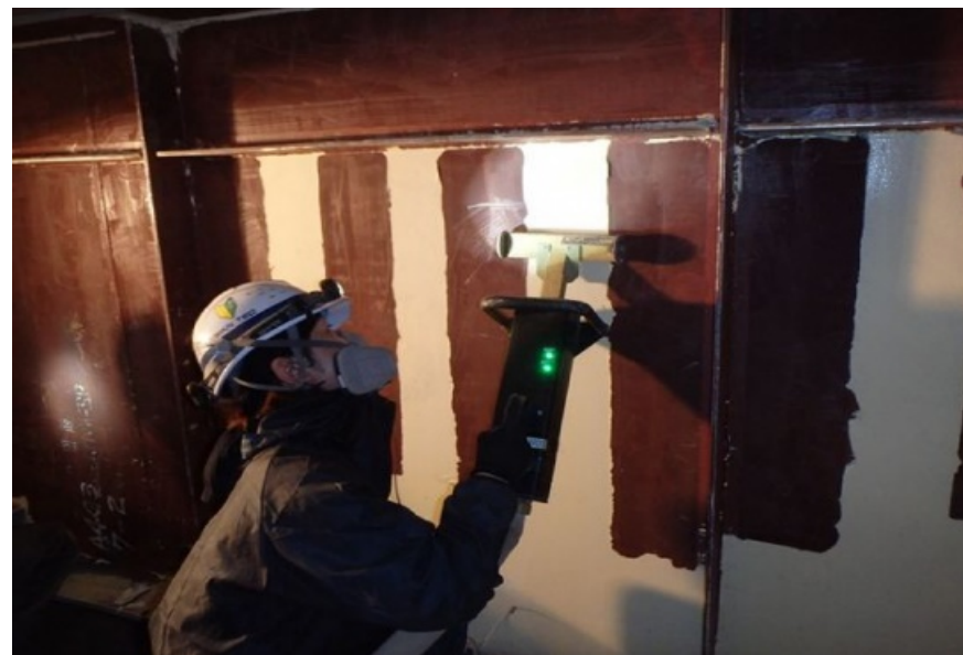
【IH塗膜除去機による加熱】
