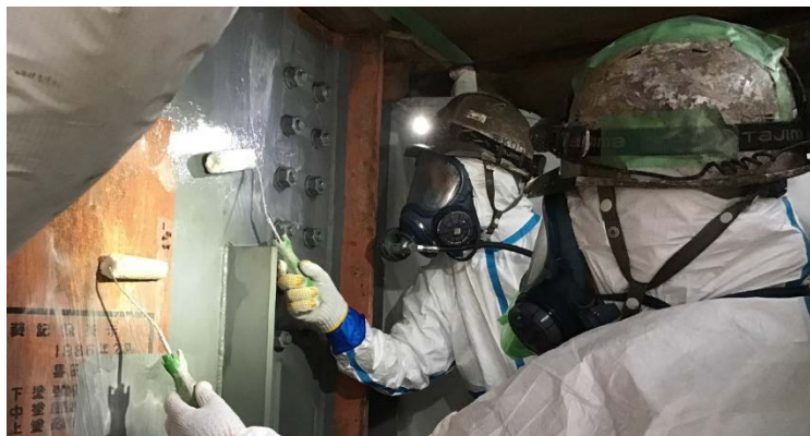
【水性塗膜剥離剤塗布状況】
