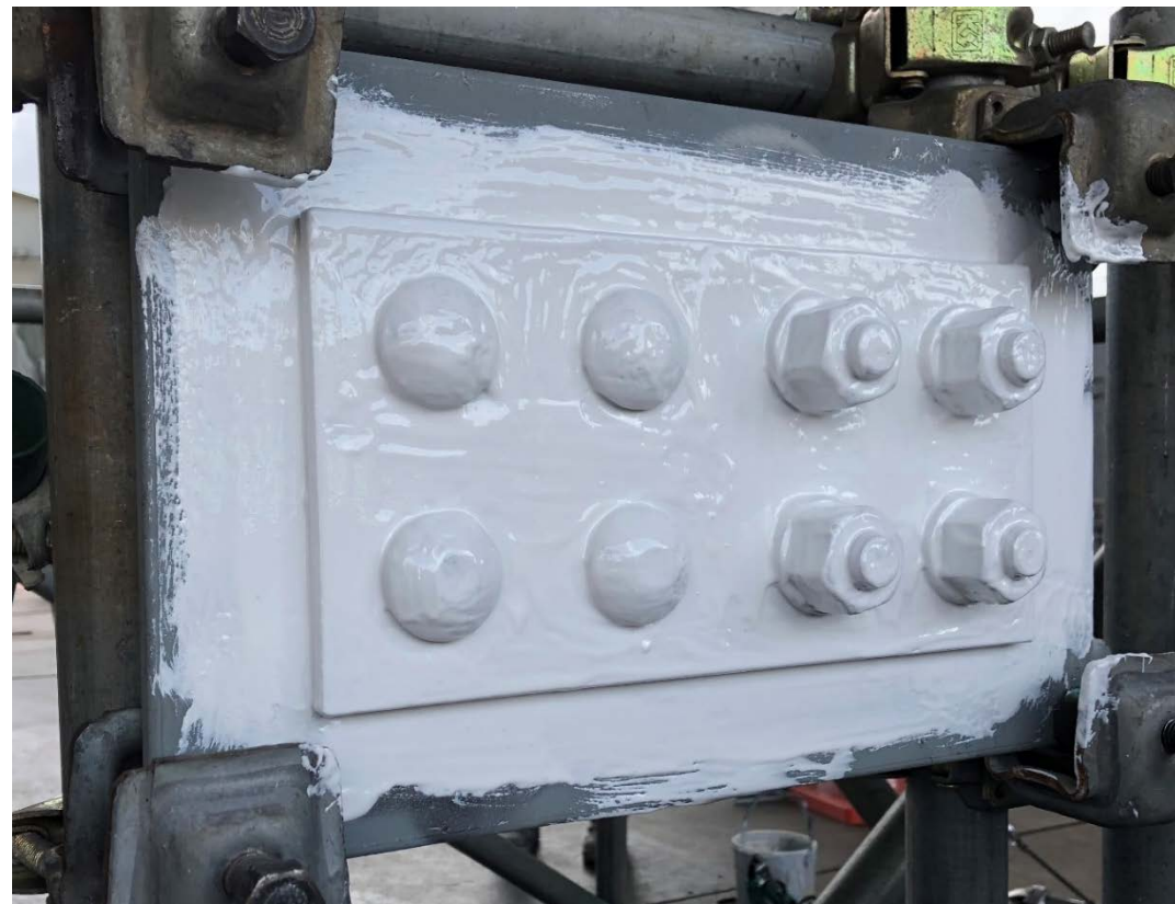
↓ 下塗り塗布完了状況
