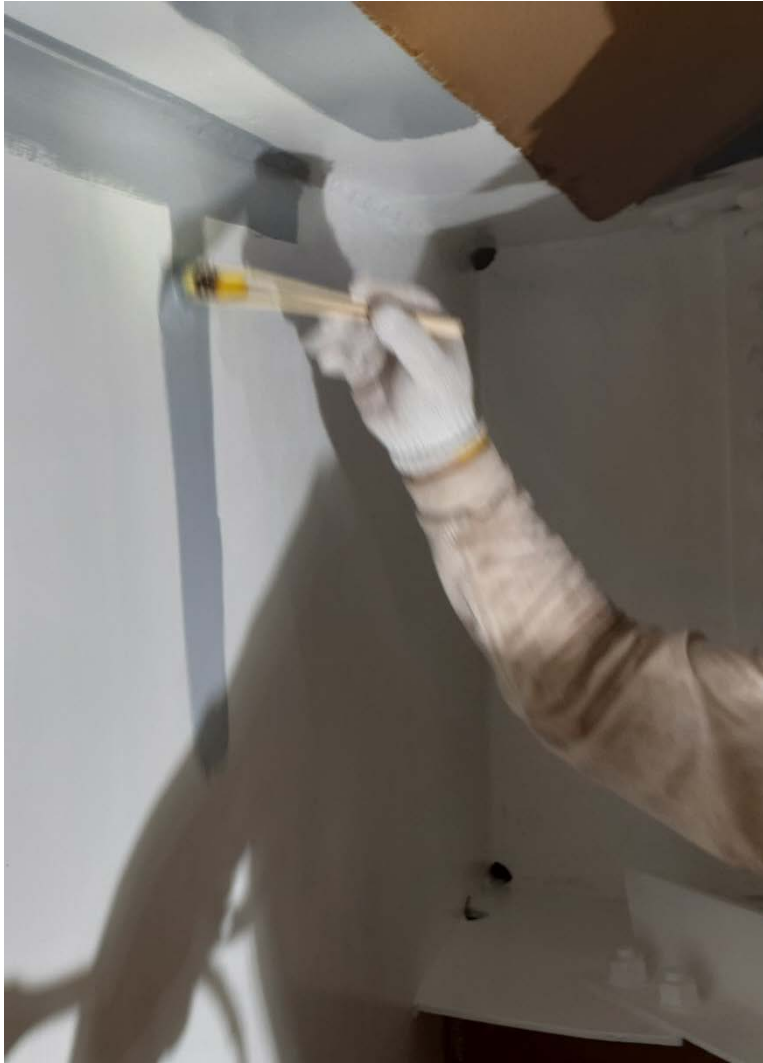
↑ 上塗り塗布作業状況
