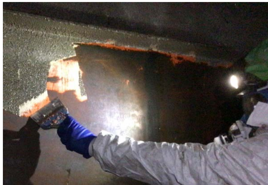
【水性塗膜剥離剤による塗膜剥離状況】
