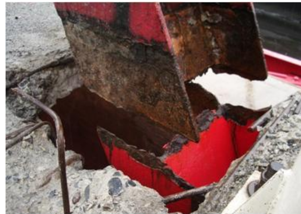
斜材の破断
