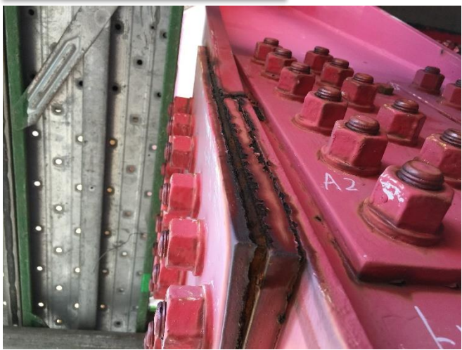
添接板隙間腐食
