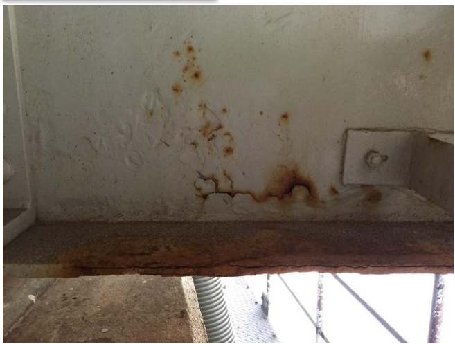
添接板隙間腐食
