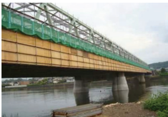
現場ブラスト作業における養生の例(トラス橋)
