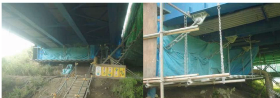
現場ブラスト作業における養生の例(I桁橋)
