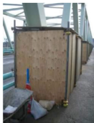
現場ブラスト作業における養生の例(トラス橋)
