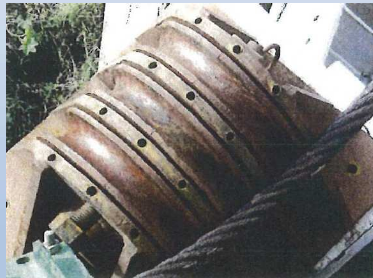
回転止め金具の挿入状況
