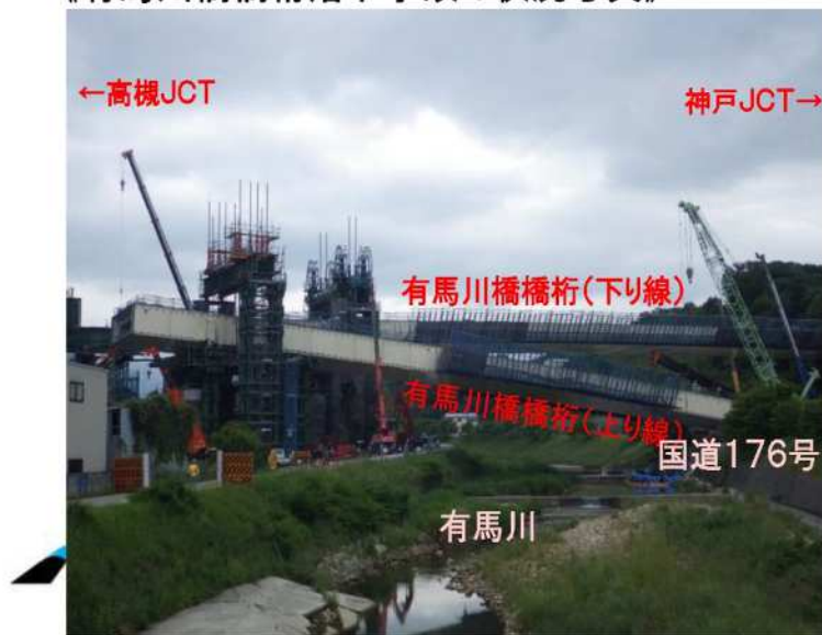
《有馬川橋橋桁落下事故の状況写真》
