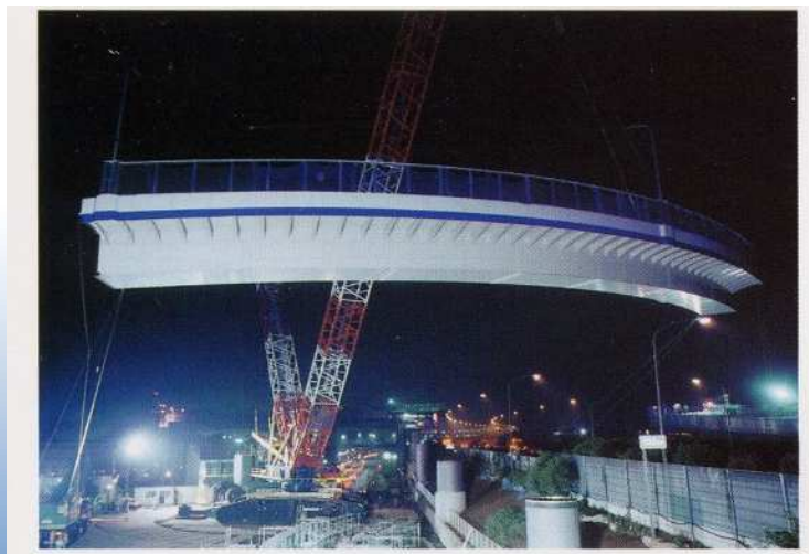
(g) 大型クレーンによる一括架設工法
