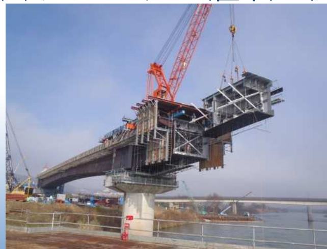
(d)トラベラクレーン片持ち工法
