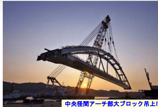
中央径間アーチ部大ブロック吊上げ
