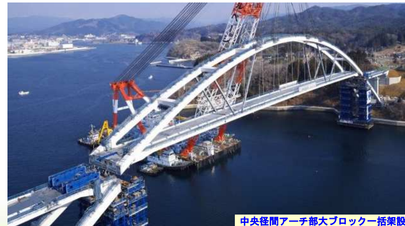
中央径間アーチ部大ブロック一括架設
