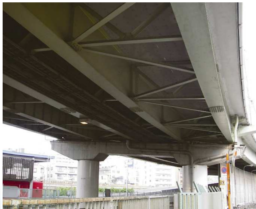
従来形式 I 桁橋(主桁が5本)
