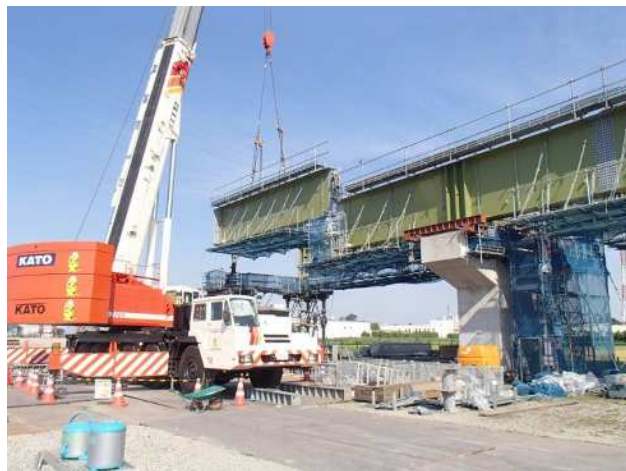
(a)トラッククレーンベント工法
