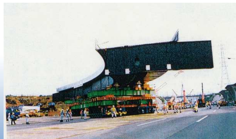
(h) 大型搬送車による一括架設工法
