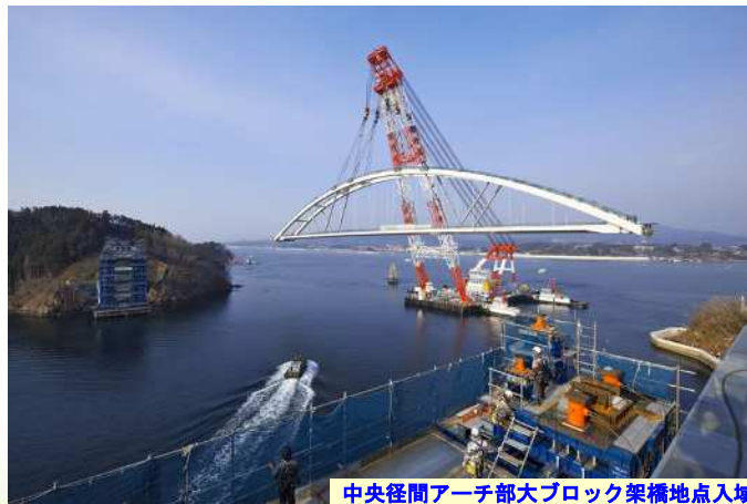
中央径間アーチ部大ブロック架橋地点入域
