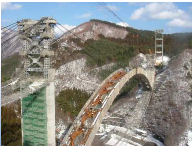
(c)ケーブルエレクション(斜吊)工法
