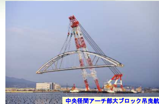
中央径間アーチ部大ブロック吊曳航
