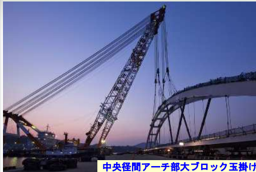
中央径間アーチ部大ブロック玉掛け
