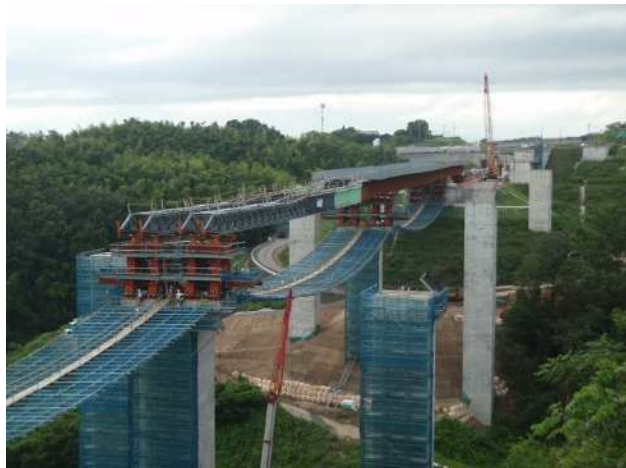
(e) 手延式送出し工法
