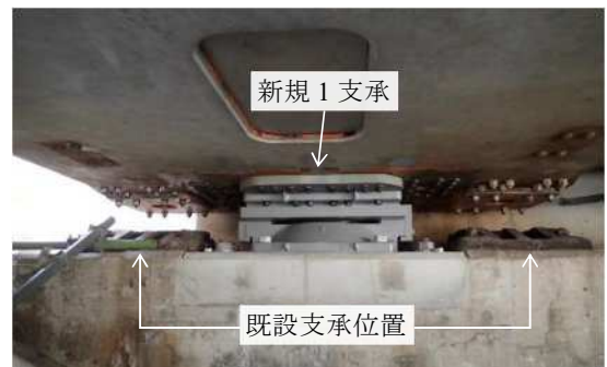
写真-2 1線1支承形式の施工例
