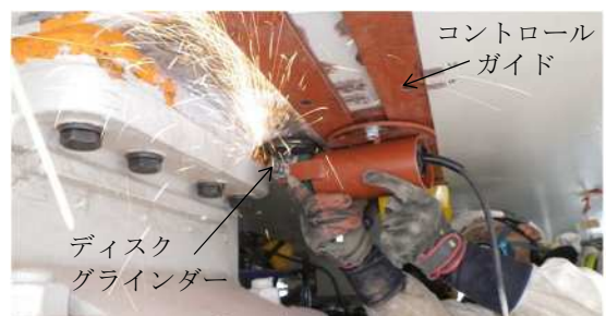
写真-3 グラインダーによるソールプレート溶接部の削除
