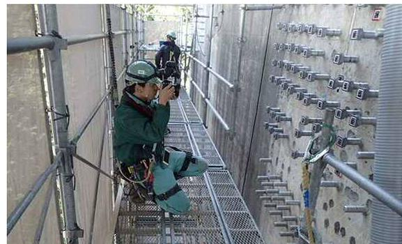
写真-2 アンカーボルト位置の計測状況
