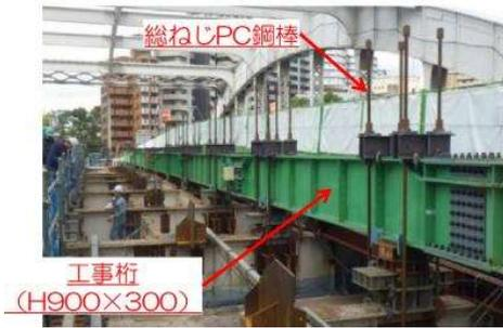
写真-9 工事桁配置状況
