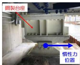
写真-14 鋼製台座設置完了
