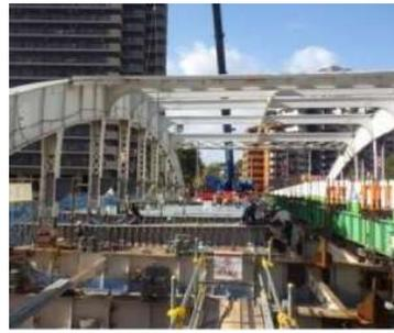
写真-10 鋼床版架設状況
