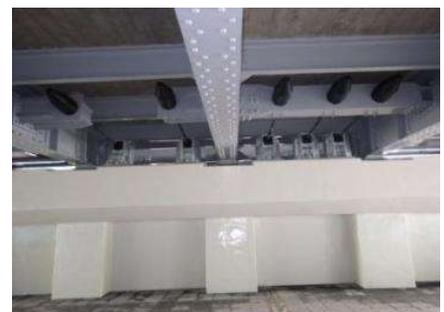
写真-21 桁間に落橋防止装置
