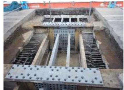
写真-18 主桁連結完了
