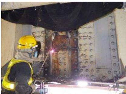
写真-16 主桁ウェブのガス切断
