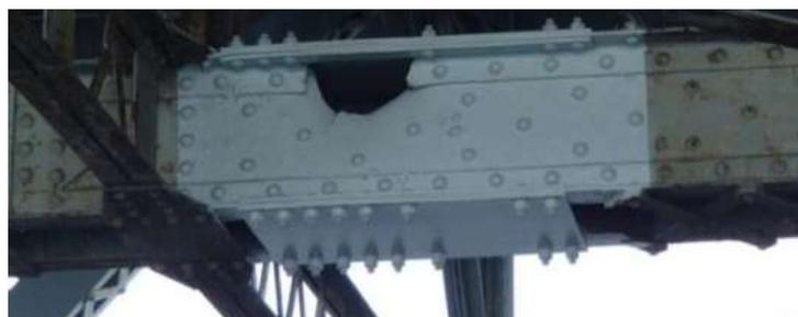
写真-6 弾痕を補修した部位
