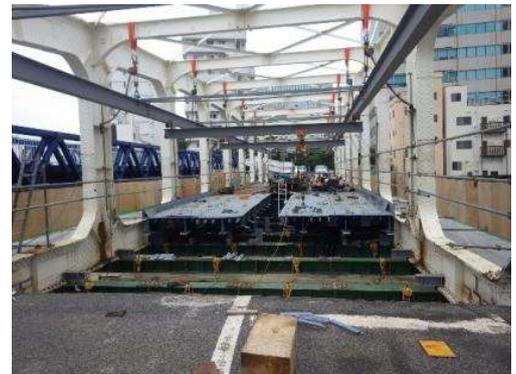
写真-12 運搬設備と鋼床版の架設状況
