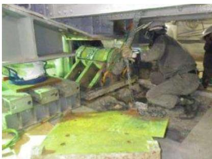
写真-19 既設ピン支承の撤去
