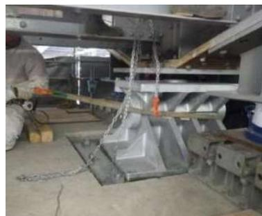
写真-20 新設ピン支承の設置
