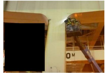
図-16 に鋼製橋脚隅角部で起きたき裂進展・加速事例を紹介する。このき裂は、横梁ウェブとカバープレートの溶接ルート部を起点とし、き裂進展に伴い応力の卓越するフィレット形状のウェブ板コバへ曲がっていき、その後、ウェブ面と柱フランジ面に進展し、柱部を水平に切断する方向に大きく進展した。原因は、構造部材でないカバープレートの溶接状態である。また、カバープレートは景観に配慮して曲線となっており、さらに横梁断面を横梁先端から柱部に向かって断面を絞る形状となっているため、カバープレートは台形の鋼板である。そのためカバープレートを設置した際には、フィレット形状のウェブとはギャップのある溶接とならざるを得ない。発生したき裂が応力の高いフィレット部に進展後は、柱母材とウェブ母材へ進展しており危険な状態であった。緊急応急対策としてストップホールとベント設置、その後、当て板補強を行っている。
