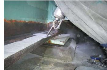
図-5 実橋における CS 施工状況
