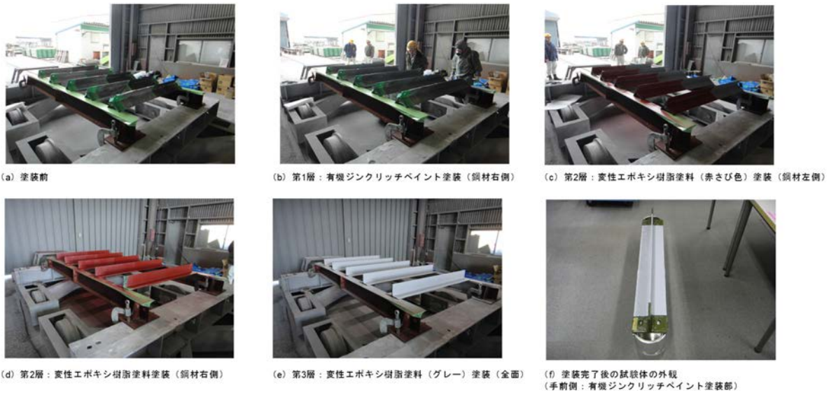
図 4.3.9 屋外暴露試験用 CT 鋼製作状況と塗装完了後の試験体の外観
