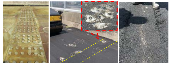
(a)特殊樹脂防水材のムラ・噴出 (b)ローラーマーク残り 図-9 樹脂防水一体型アスファルト舗装の施工状況
