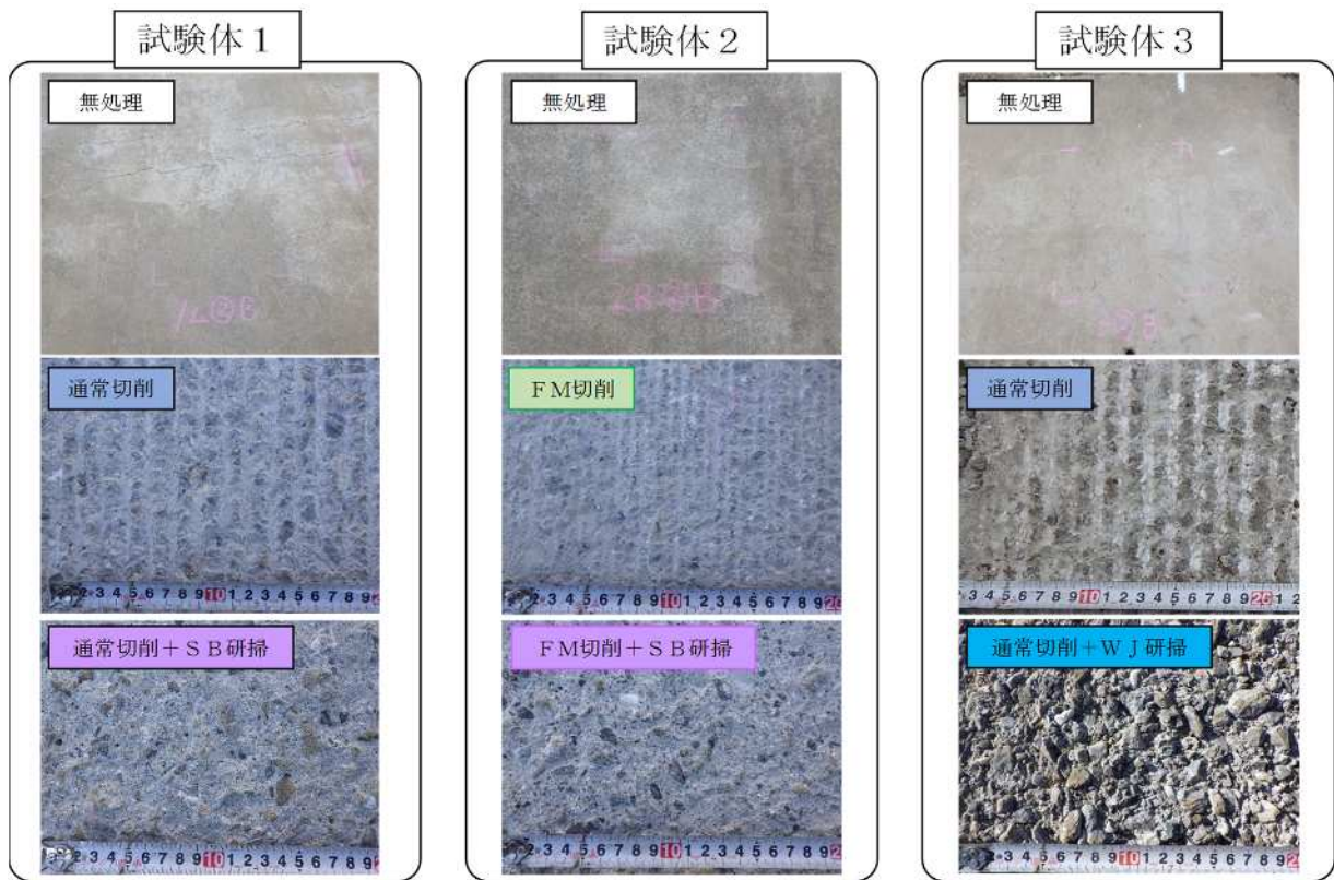
写真-3 切削及び研掃後の床版上面状況
