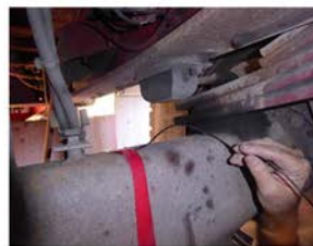
図-7 加速度計設置の様子
