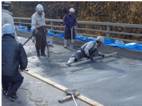
写真-1 施工状況
