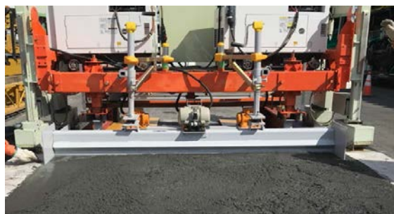
写真-2 UHPFRC の締固め状況
