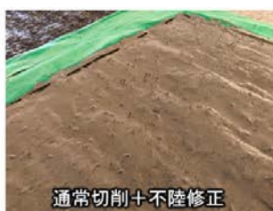
写真-6 通常切削+不陸修正 (ケース0-③)
