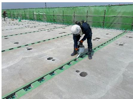
写真-7 間詰め部の施工状況
