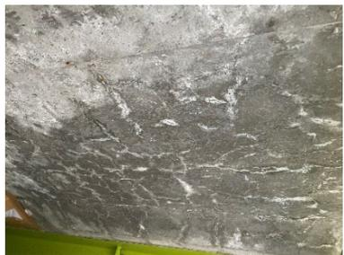
写真-3 床版下面の格子状のひび割れ
