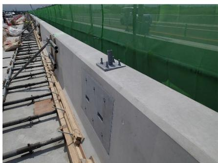
写真-8 プレキャスト壁高欄の施工状況
