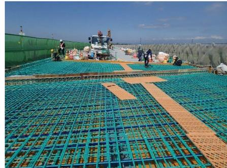
写真-3 場所打ちPC床版施工状況
