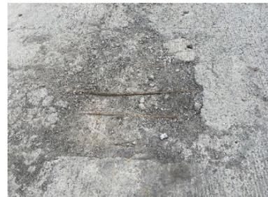
写真-1 床版上面の土砂化と鉄筋の腐食
