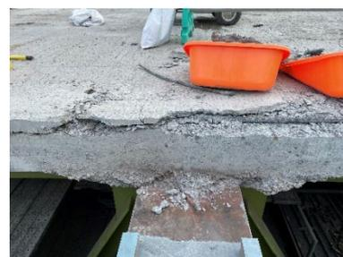
写真-2 水平ひび割れ
