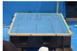
(2)接着剤塗布および メタルグリッド筋配置
