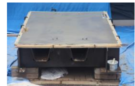
(4)表面仕上げ・養生
