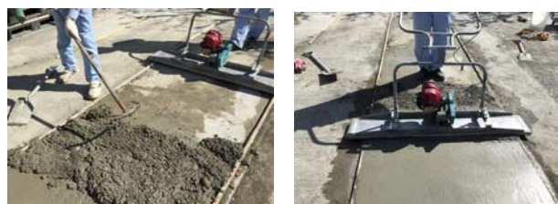
(a)練混ぜ後 (b)施工後 図-7 簡易フィニッシャによる施工状況
