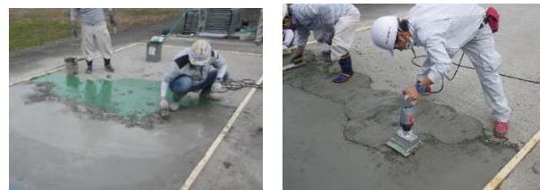
(a)接着剤塗布状態 (b)敷き均しと仕上げ 図-6 試験施工状況
