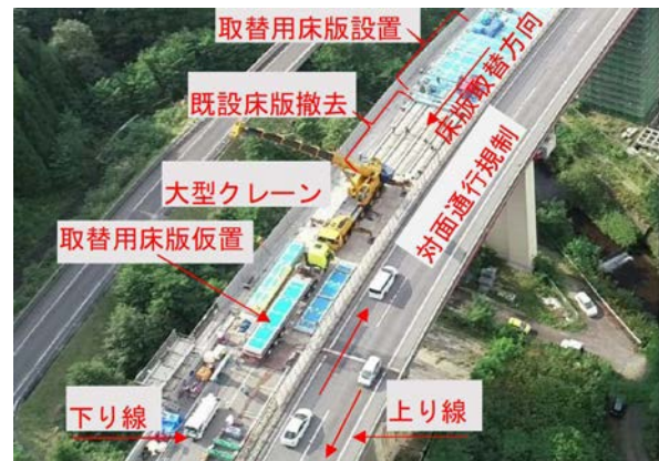
写真-1 床版取替工事に伴う通行規制概要
