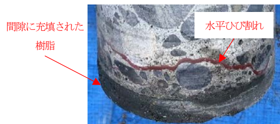
写真-6 貼替工法における樹脂の充填状況
