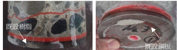
写真-5 浮きへの充填状況
