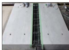
(a) 取替RC床版設置
