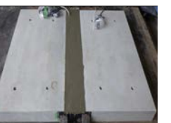
(d) 取替RC床版完成
