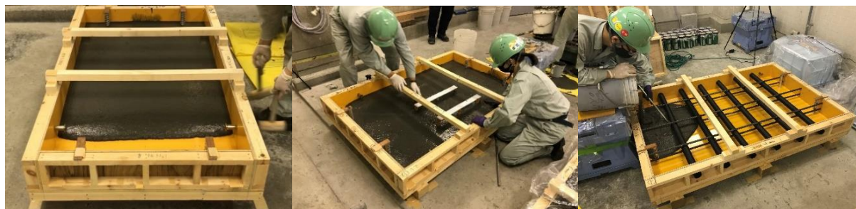
写真-1 テスト床版作製状況（左：ひび割れ床版，中：浮き床版，右：PC 鋼材破断床版）
