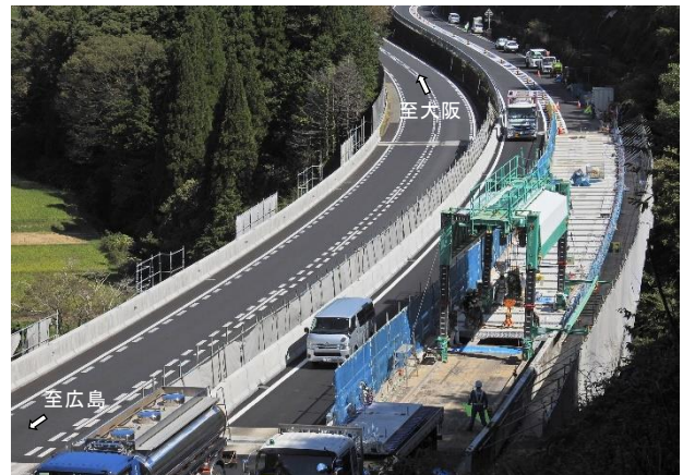
写真-1 大谷橋施工状況(下り線2期施工)
