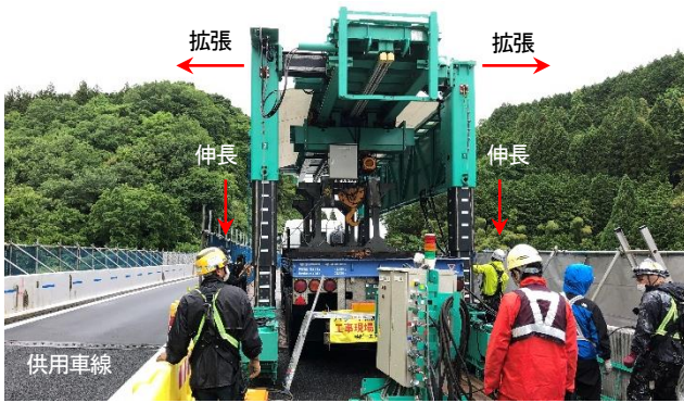
写真-7 架設機の設置
