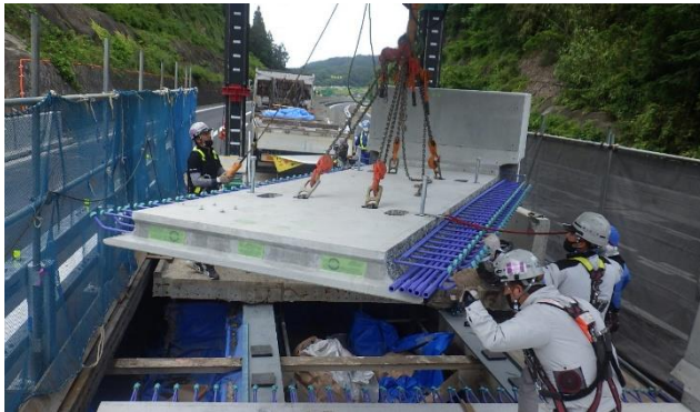
写真-8 追越し側床版の架設状況
