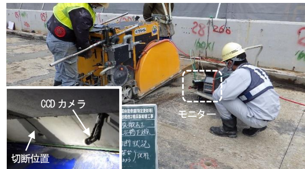
写真-6 CCDカメラによる床版下側の確認
