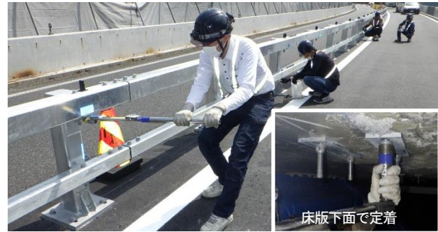
写真-5 仮設防護柵(既設床版)の設置状況
