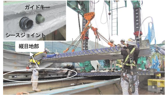
写真-10 走行側床版の架設状況
